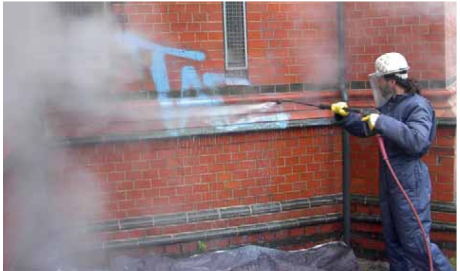
Hier wird die beschmutzte Wand mit Hochdruck abgestrahlt.
