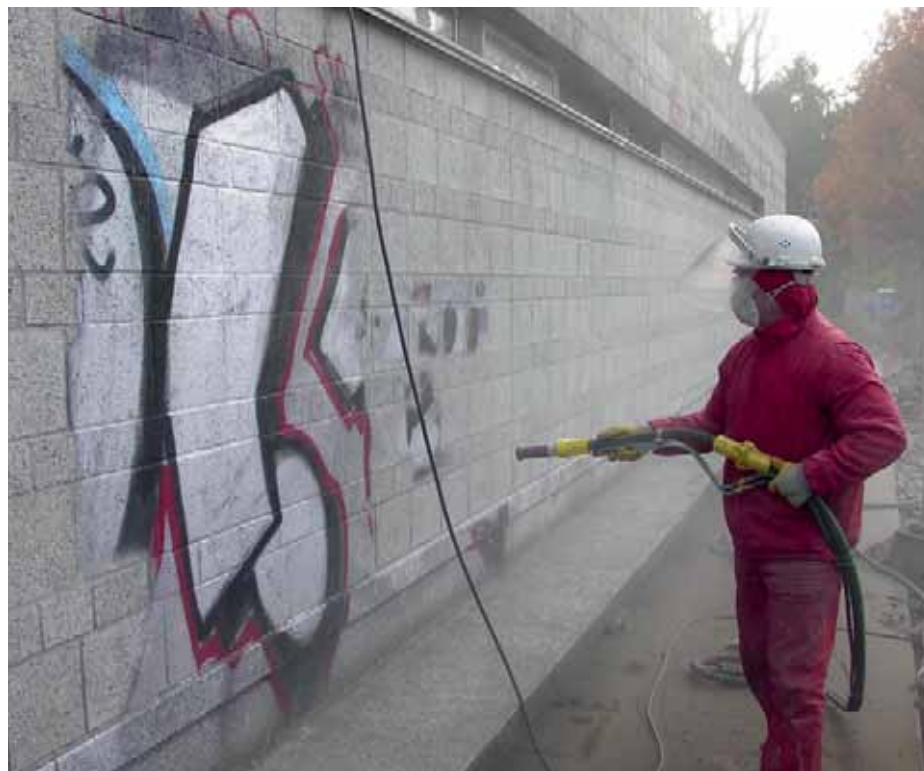
Das Glaspuderstrahlen eignet sich gut, um Natur- und Kunststein von Graffiti zu befreien.
